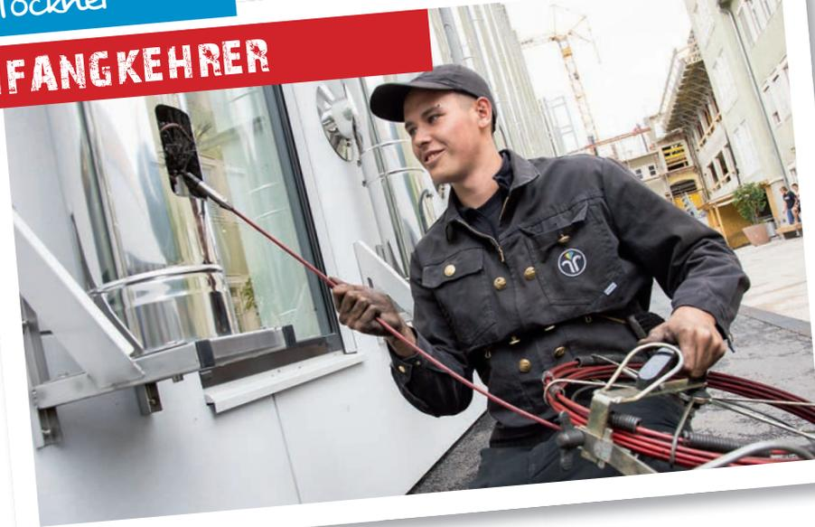
◆ Sandro Tockner bei der Arbeit: Gewissenhaft werden brennbare Rückstände entfernt
